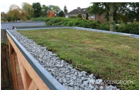
Figuur 14: Lichtgewicht dak
